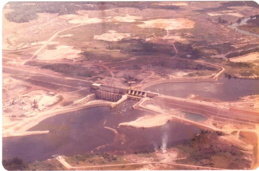
Imagem 1: Acervo Milton Salgado e Arminda Mendonça de Souza Vista aérea da UHE Balbina
