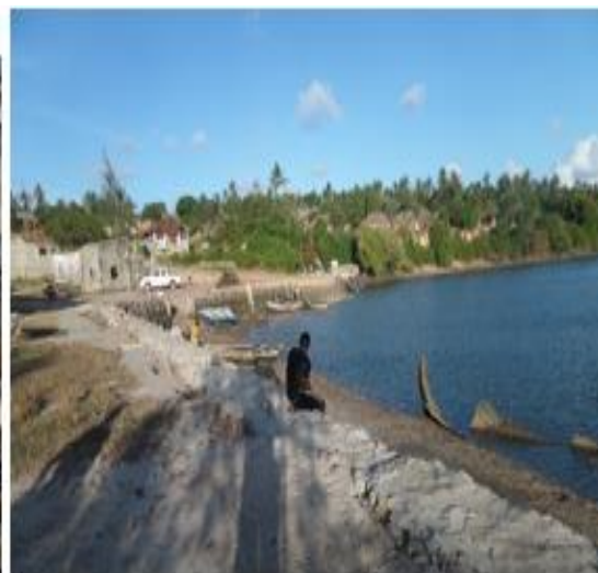
Fig 5 B Barreira de cimento e rochas sob solo inconsistente
