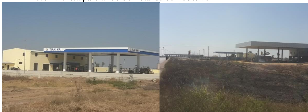
Foto 1: Vista parcial de bombas de combustível
