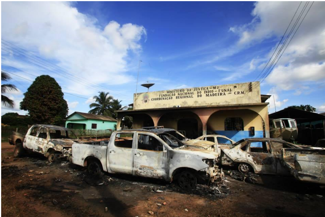
Figura 3 - FUNAI após incêndio criminal realizado por cidadãos humaitaenses. Fonte: Acrítica de Humaitá, 2014.
