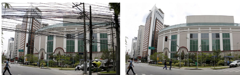
FIGURA 3 À esquerda, fiação exposta em frente à fachada do shopping Vila Olímpia, na zona oeste de São Paulo. À direita, como ficaria a mesma esquina se a fiação fosse enterrada (imagem manipulada).
