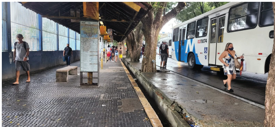
FIGURA 8 Abrigos abaixo do nível da rua. Fonte: Autores, 2022.
