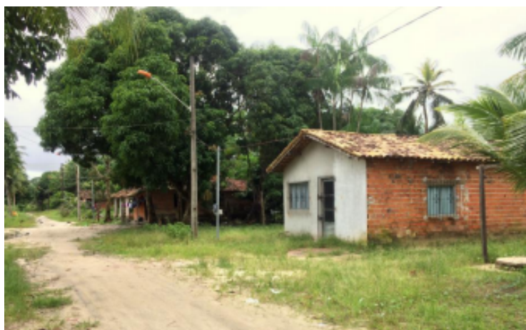
Figura 05 - Residência unifamiliar Agrovila
