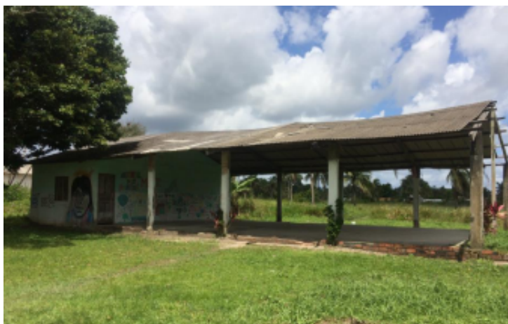
Figura 06 - Centro Comunitário localizado na Agrovila .
