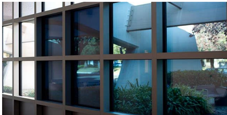
Figura 5 – Efeito do vidro termocrômico
