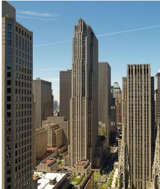
Figura 2 – Edifício Rockefeller Plaza
