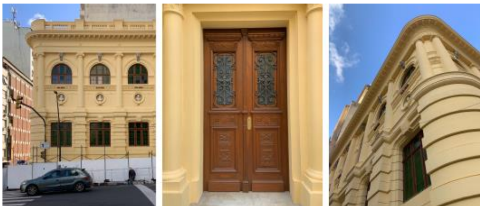
Figura 06, 07 e 08 - Detalhes da fachada do Prédio (durante a reforma).
