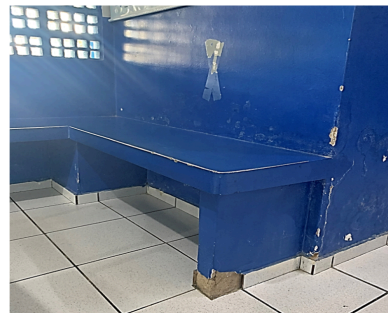
4. Banco linear em concreto armado
