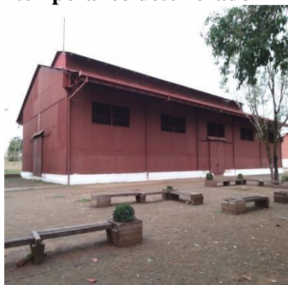
Figura 1: Vista de um dos armazéns da EFMM e de seu jardim contemporâneo deteriorado
