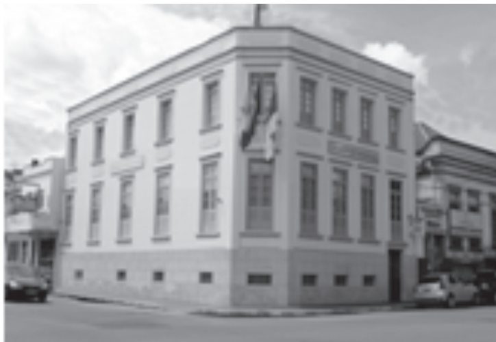
Figura 4 - Antigo prédio da Escola Comercial Lopes Gonçalves, Rua 10 de julho, n. 11, atual Faculdade do SENAC, (2013).
