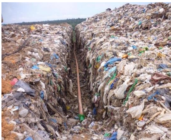
Figura 4: Instalação de um Dreno horizontal. Fonte: Autor, (2018).
