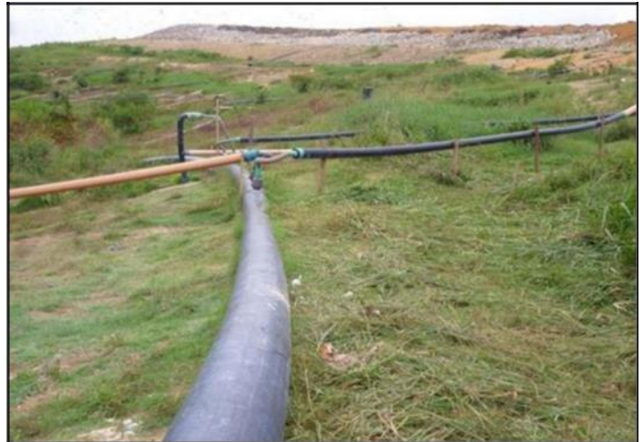
Figura 5: Tubulação de coleta em PEAD 315 mm. Fonte: Autor, (2018).
