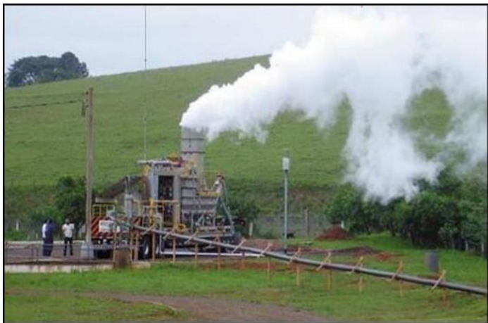
Figura 17: Evaporador de chorume em operação no Aterro de São Leopoldo-RS. Fonte: [22].
