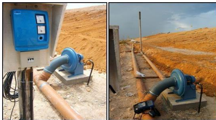
Figura 1: sistema piloto de captação de biogás. Fonte: Acervo do Aterro de Manaus.
