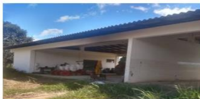
Prédio da Garagem/oficina
