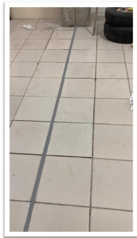
Figura 18: Tratamento de junta de dilatação.
