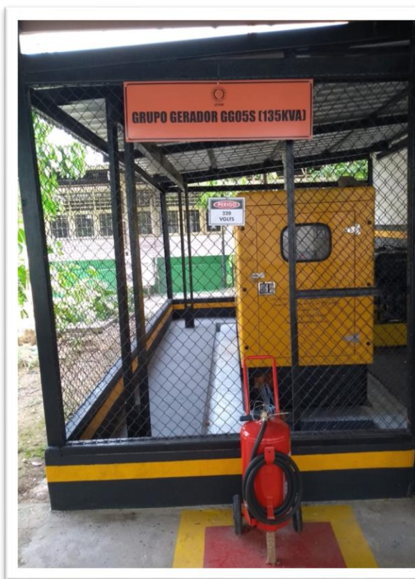
Figura 27: Manutenção em abrigo de geradores.
