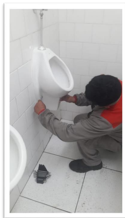
Figura 7: Manutenção em instalações hidráulicas.
