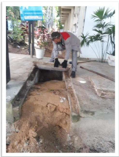
Figura 4: Desobstrução de calhas entupidas.
