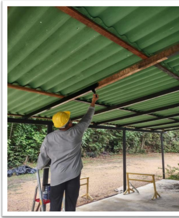
Figura 15: Pintura da estrutura de cobertura.
