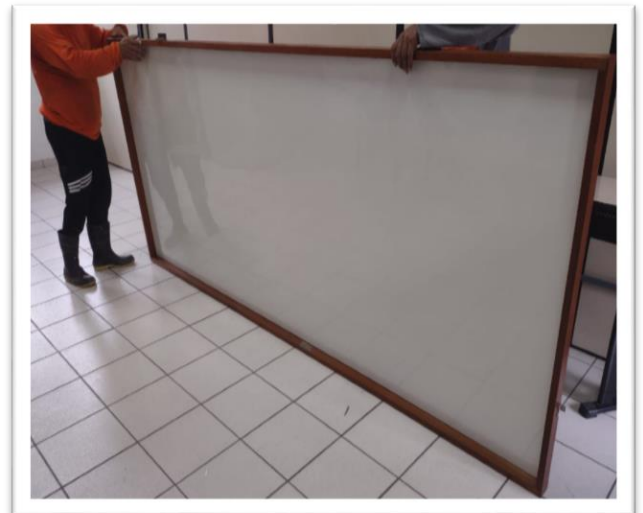
Figura 21: Instalação de novos quadros brancos.
