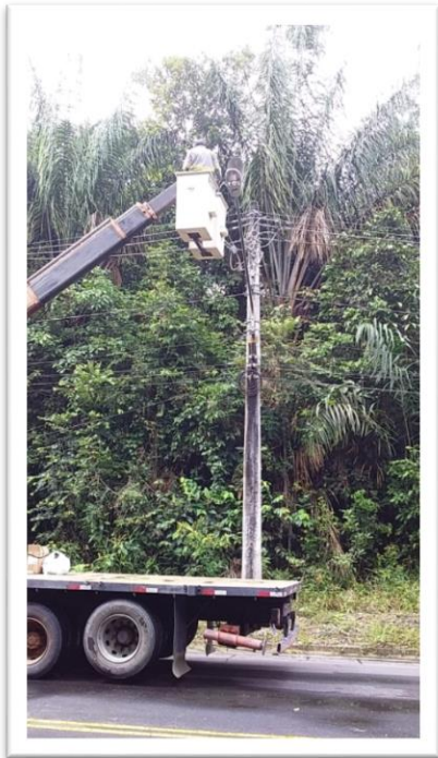
Figura 24: Manutenção na iluminação de vias.
