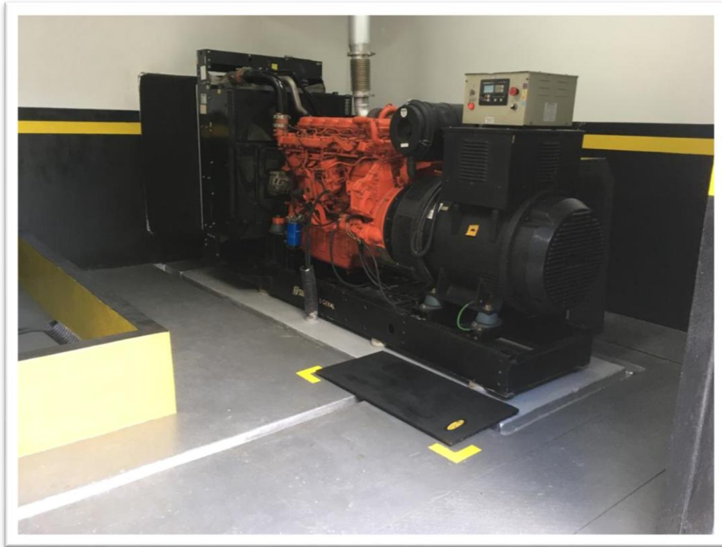
Figura 28: Manutenção em grupo gerador.
