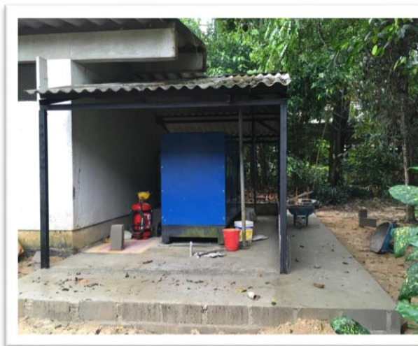
Figura 26: Manutenção em abrigo de geradores.
