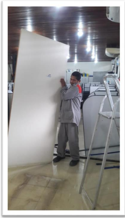
Figura 8: Movimentação de divisórias.
