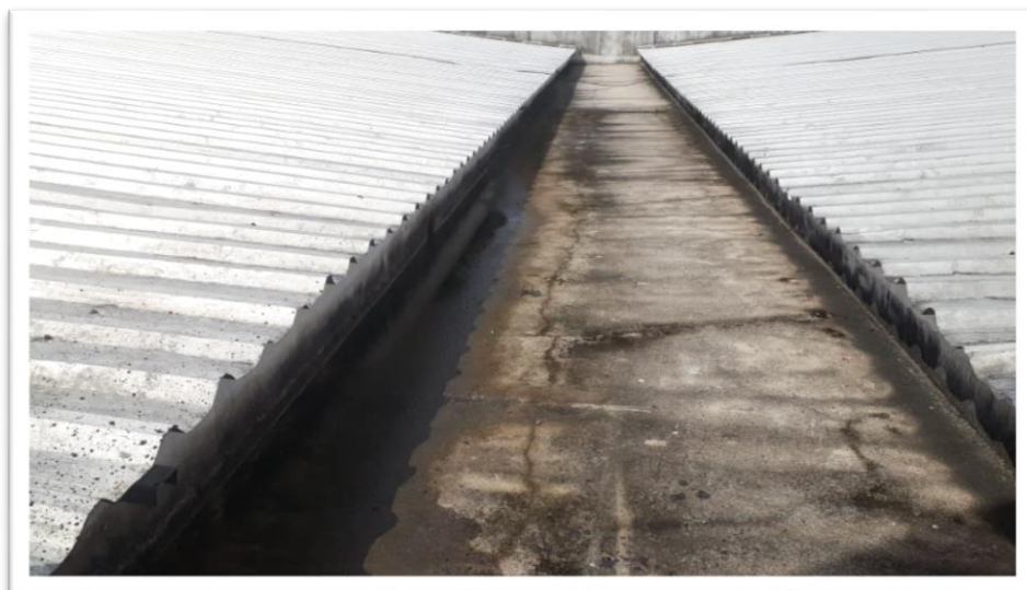
Figura 3: Limpeza de calhas.
