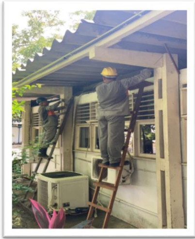
Figura 11: Isolamento de forro.
