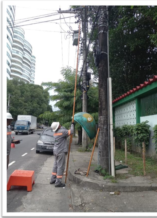
Figura 23: Manutenção na entrada da rede elétrica.
