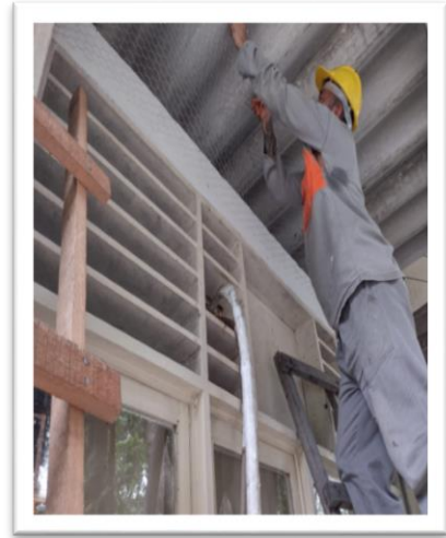
Figura 12: Isolamento de forro.
